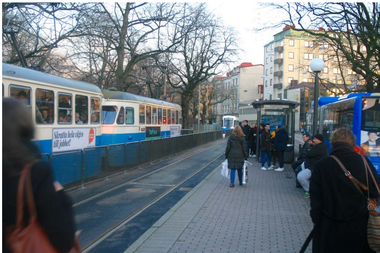
Hållplats Haga Kyrka vid blivande station Haga, Västlänken
